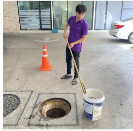
รูปที่ 2-5 การกำจัดไขมันจากถังดักไขมัน
