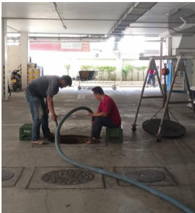
รูปที่ 2-4 การสูบลากตะกอน
